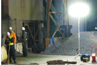
Reparación de Carretera
