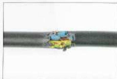
Cable eléctrico dañado
